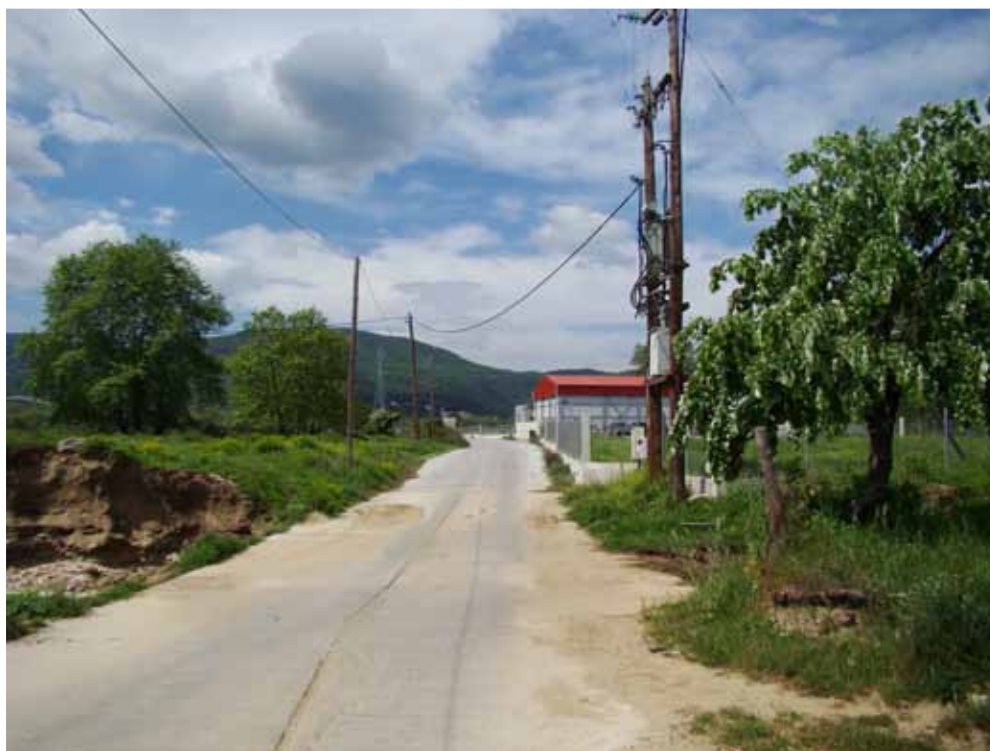
Φωτογραφία 15. Προς παλιό εργοστάσιο εμπλουτισμού (σημείο 13)
